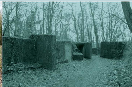
Fort d'Illange Parapet d'infanterie en béton
